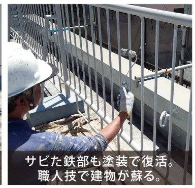
全て手作業。劣化を落とし下地作りが塗装の肝。
